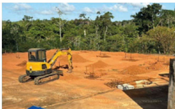
Hangar presse à balle – Papaïchton
