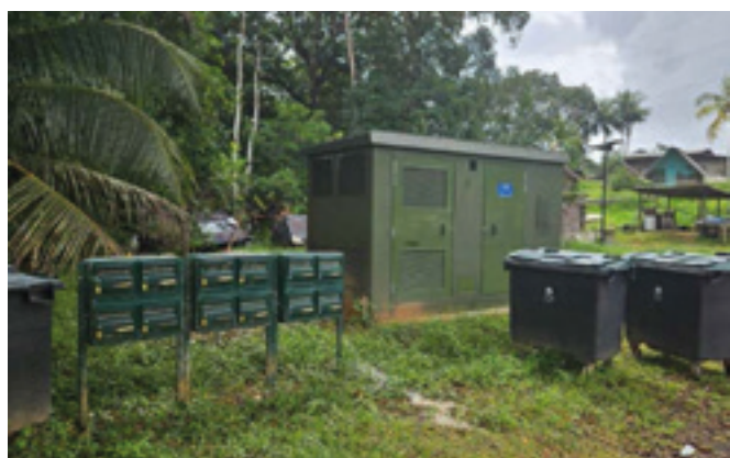
Electrification du village Gotali à Mana
