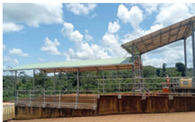
Hangar presse à balle – Papaïchton
