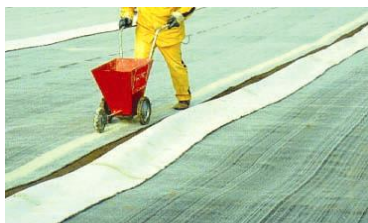
Soudure du GSB à la bentonite
