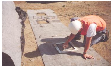
Test de contrôle in situ de la qualité du géotextile synthétique bentonitique (GSB)
