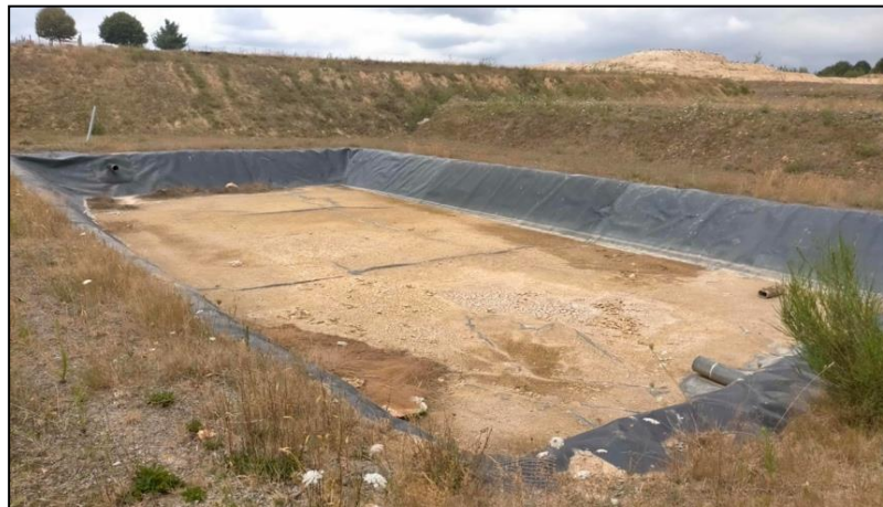
Exemple d'un bassin de contrôle
