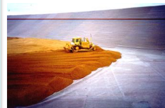
Mise en place de la couche drainante
