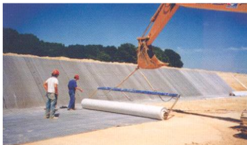
Pose des rouleaux de membrane en GSB
