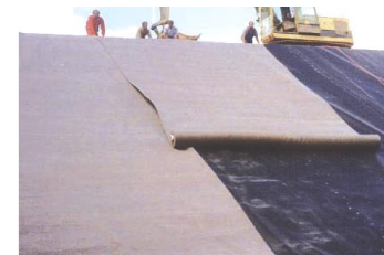
Mise en place du géotextile sur la géomembrane
