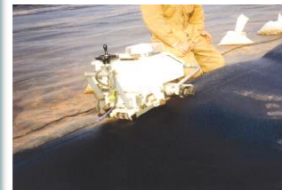
Mise en place de la géomembrane double soudure à canal central
