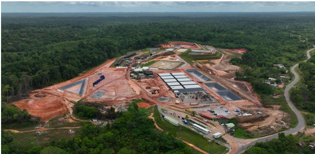
Figure 88 : L'ensemble du site vu depuis drone (Source : DLVR)
