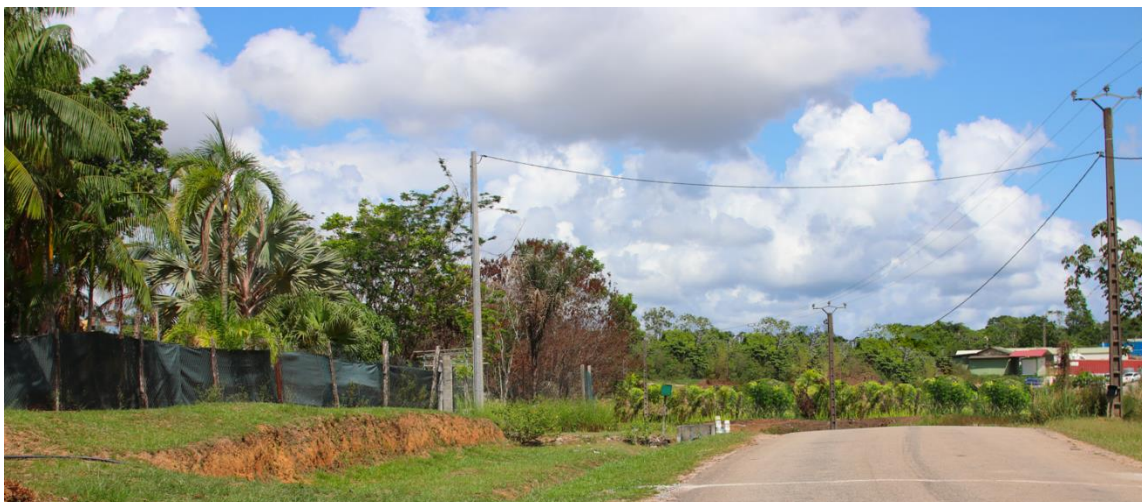
Figure 122 : Mise en place de haie arbustive le long de la clôture de la route Source : (DLVR)
