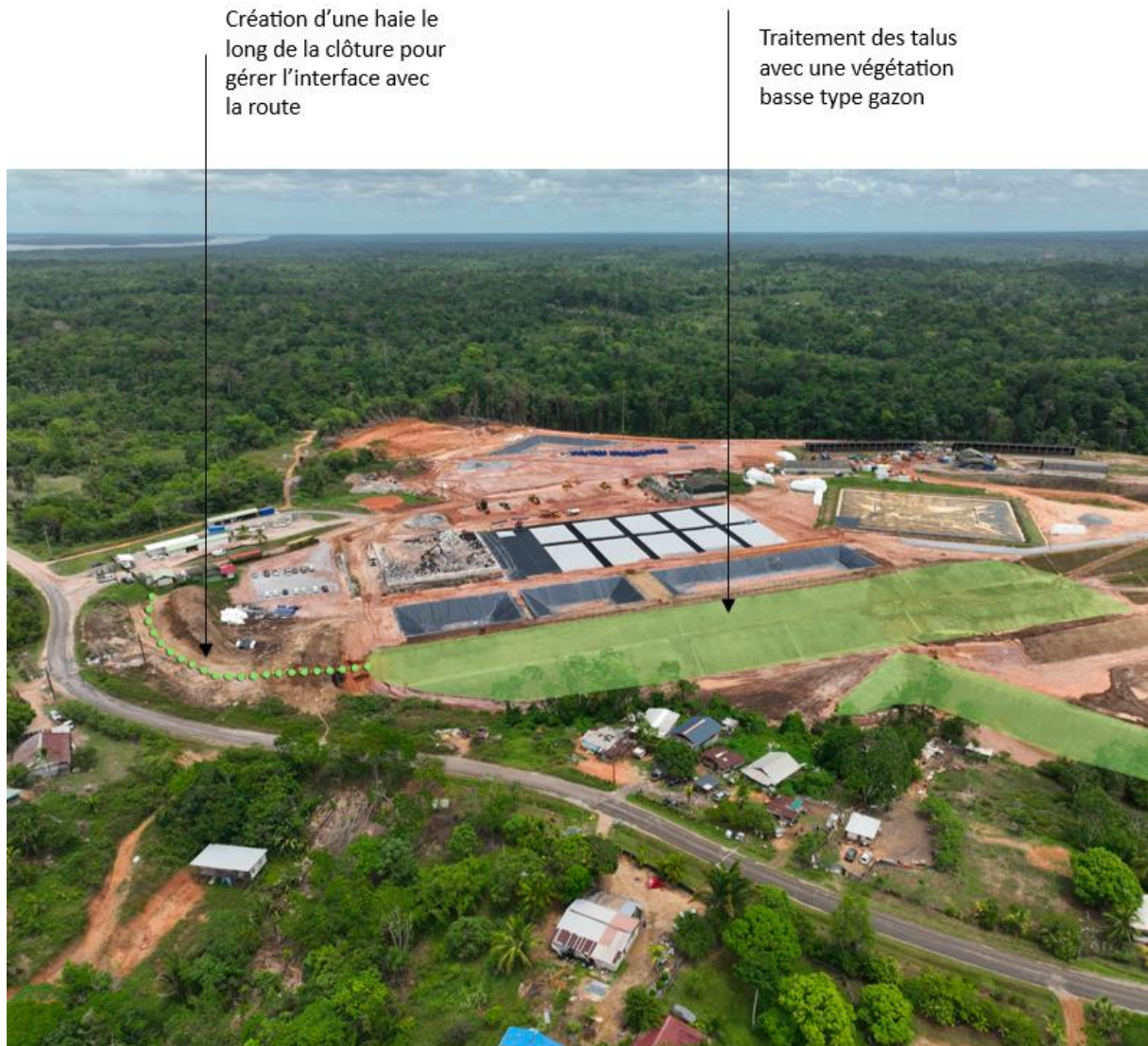
Figure 120 : Photo prise par drone (Source : DLVR)
