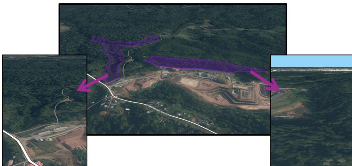
Figure 125 : bassins versants drainantes les eaux pluviales de la partie Nord du site
