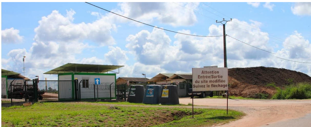
Figure 86 : Zone d'accueil depuis la route de Paul Isnard (Source : DLVR)
